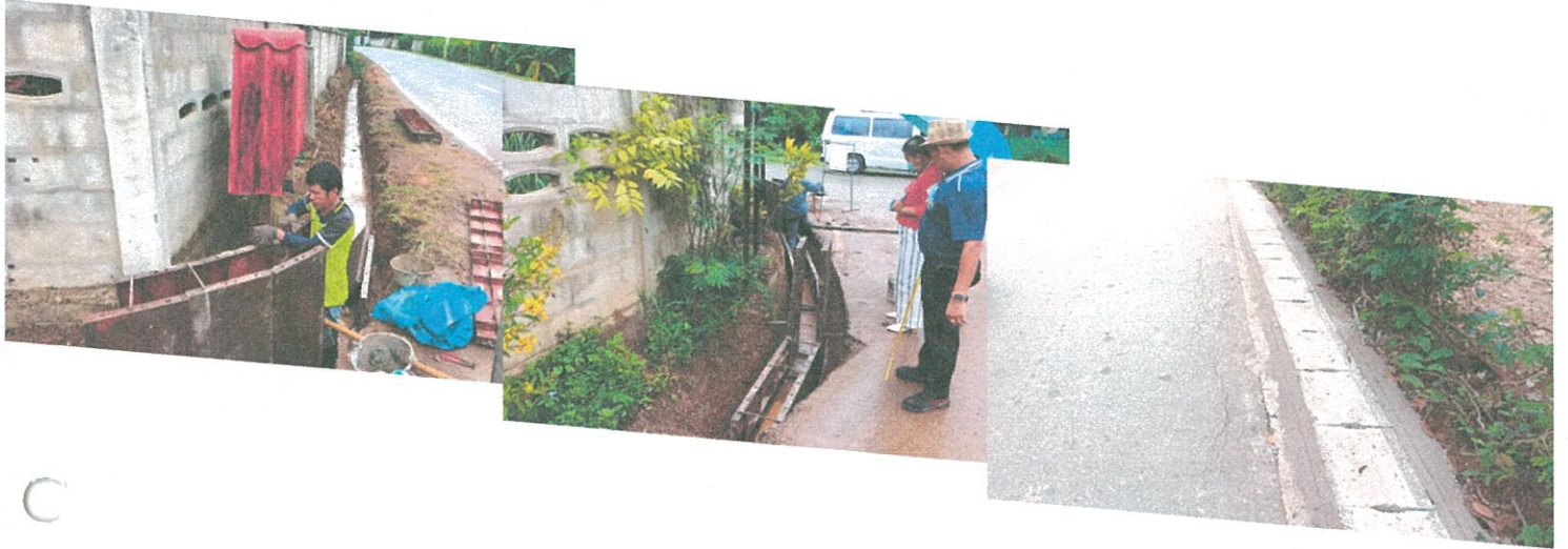
โครงการก่อสร้างรางระบายน้ำคอนกรีตเสริมเหล็กมีฝาปิด หมู่ที่ 1 ต.น้ำชำ
