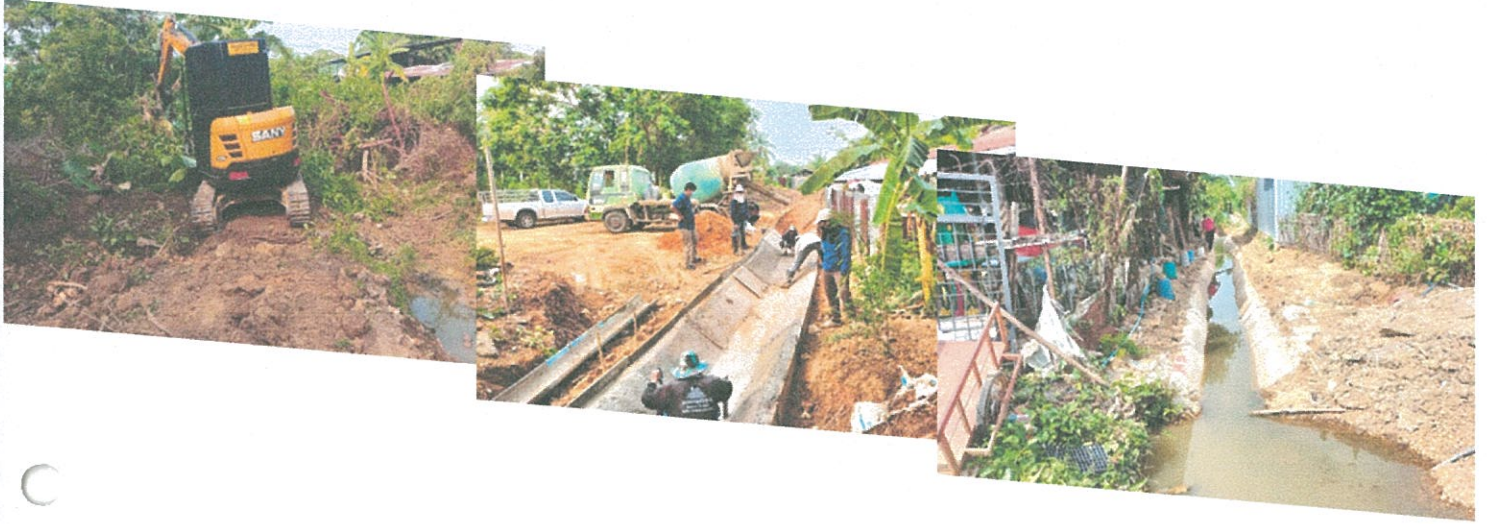
โครงการก่อสร้างตลาดน้ำเมืองคอนกรีตเสริมเหล็ก หมู่ที่ 4 ตำบลร่องฟอง
